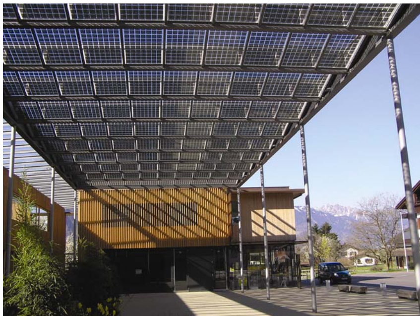
Pogled odozdo na krovnu konstrukciju sa sunčanim pretvornicima
